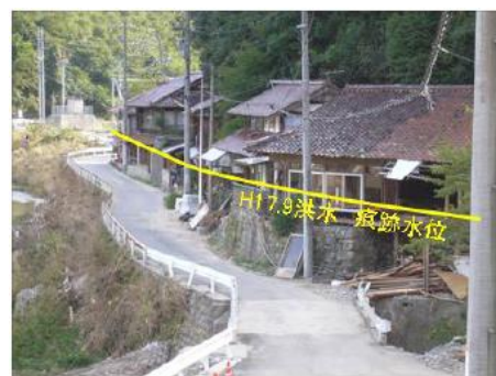
中流部の被災痕跡水位
