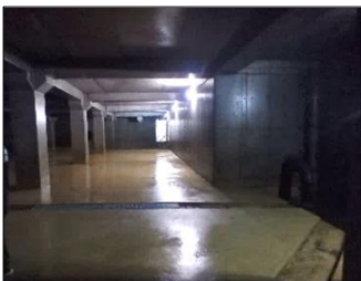
雨水貯留池内部
