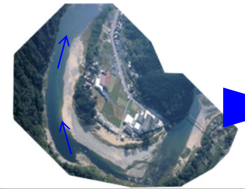
□ H17年11月(工事前) 斜め写真
