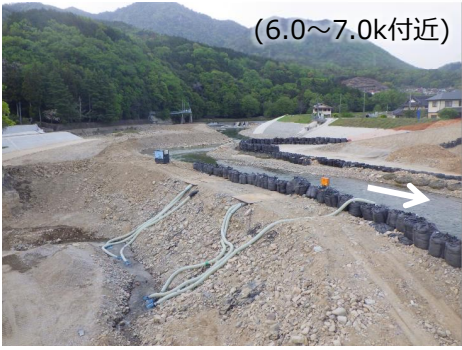
河川改修が進む6.4k付近 (令和5年4月撮影)
