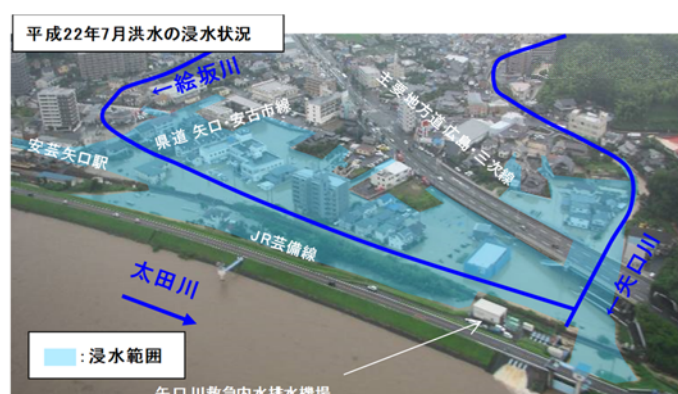
図-4.6.1 平成 22 年 7 月洪水による浸水状況
