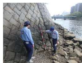
堤防点検の状況
