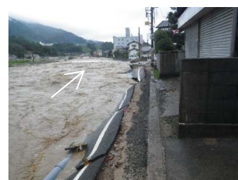
安佐北区可部地区の被害状況
