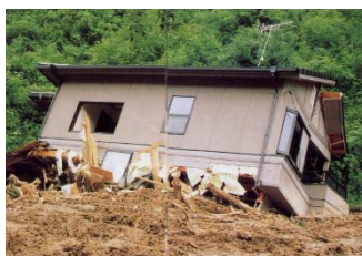
土石流による被害状況(民家流出)
