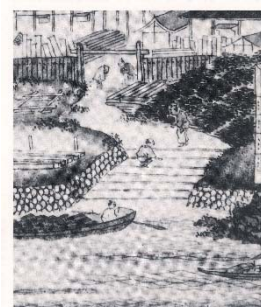
御材木場の量水標(右端の角棒) 出典：新修広島市史「江山一覧図」
