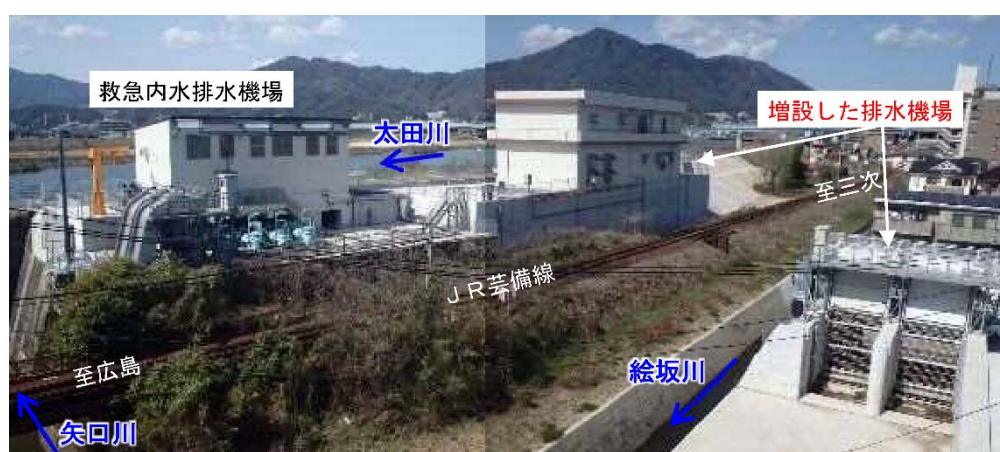
図-4.6.2 矢口川と排水機場
