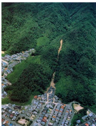
安川左支川の土石流氾濫状況
