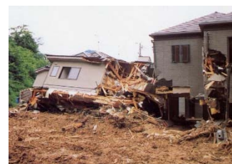
土石流による被害状況
