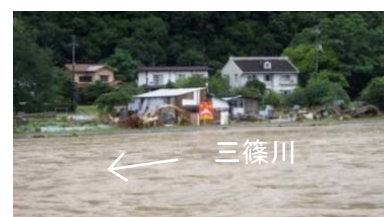
三篠川右岸 3k000 付近の溢水
