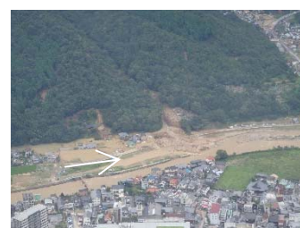
安佐北区可部東地区 の被害状況
