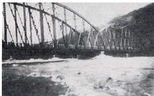
昭和 26 年ルース台風による出水状況(太田川橋付近)
