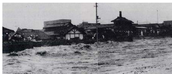
昭和 47 年 7 月豪雨 根谷川出水状況
