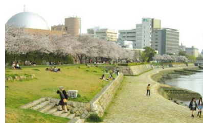
基町環境護岸(玉石護岸・桜並木)
