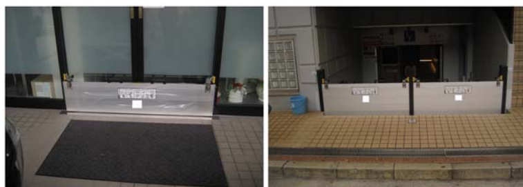
止水板の設置状況
