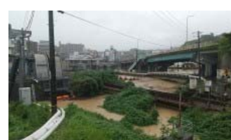
太田川 左岸 11.4k (内水) 堤内側浸水
