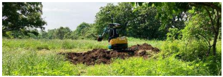
重機を使用して外来植物の除根や湿性植物移植のための掘削を実施
