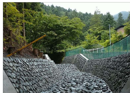
④溪流保全工（金山沢／秩父市）
