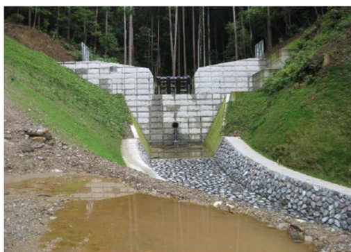
③砂防堰堤（滝山・萬開沢／ときがわ町）
