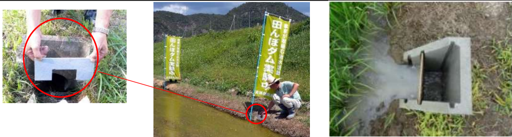
「田んぼダム」の概要（水田貯留機能強化）
