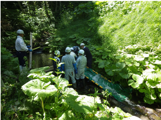
簡易魚道の設置
