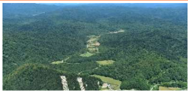
留萌川源流部（KP55.0付近）
