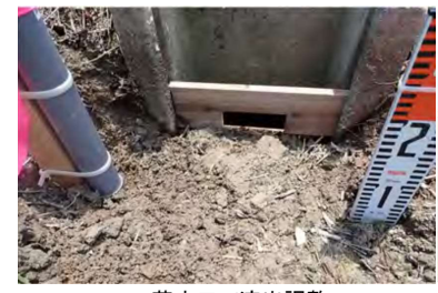
落水口で流出調整 (田んぼダムの手引きより引用)
