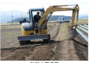
畦畔の再構築 (田んぼダムの手引きより引用)
