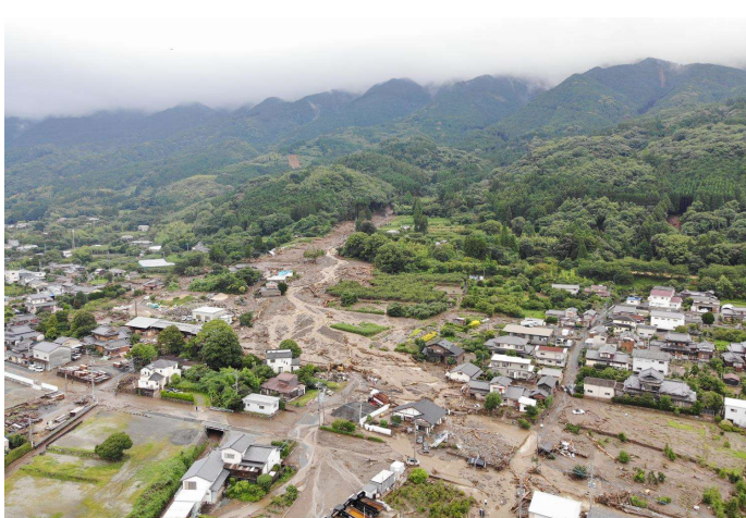
令和5年7月豪雨土砂災害の状況(久留米市)
