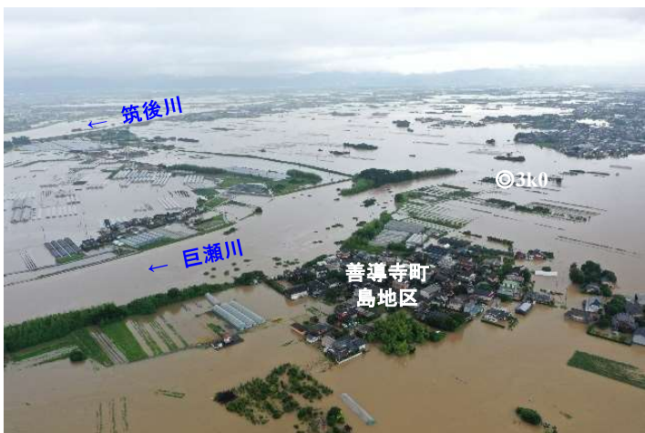
令和5年7月豪雨 浸水状況(久留米市)
