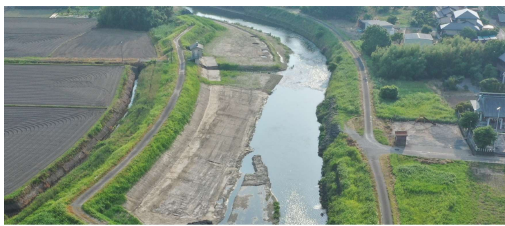
河道掘削(中尾地区)
