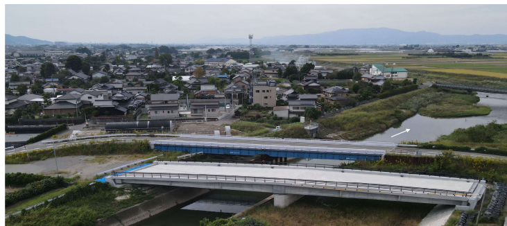
橋梁改築(小屋場橋)
