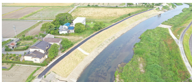
堤防整備(竹野地区)
