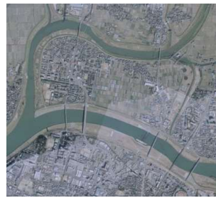
小森野捷水路(久留米市)
