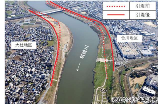
合川・大杜地区の引堤工事
