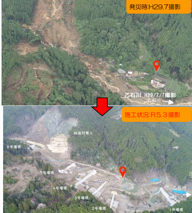
【乙石川上流堰堤群、斜面崩壊地】
