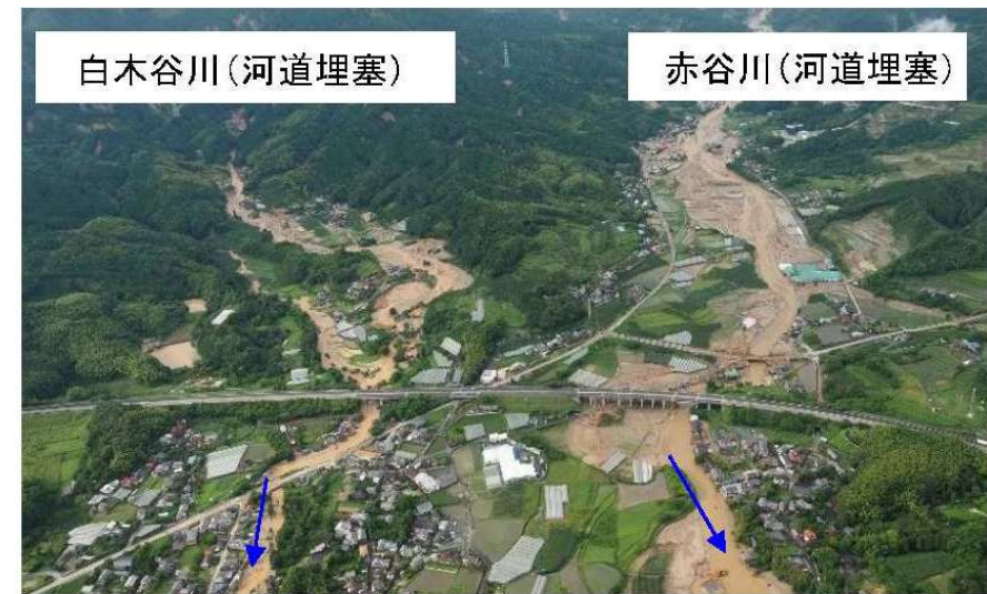
平成29年7月豪雨時の赤谷川、白木谷川の被害状況
