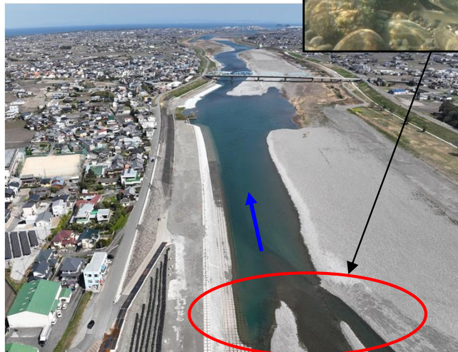
施工後 (No. 3付近)
