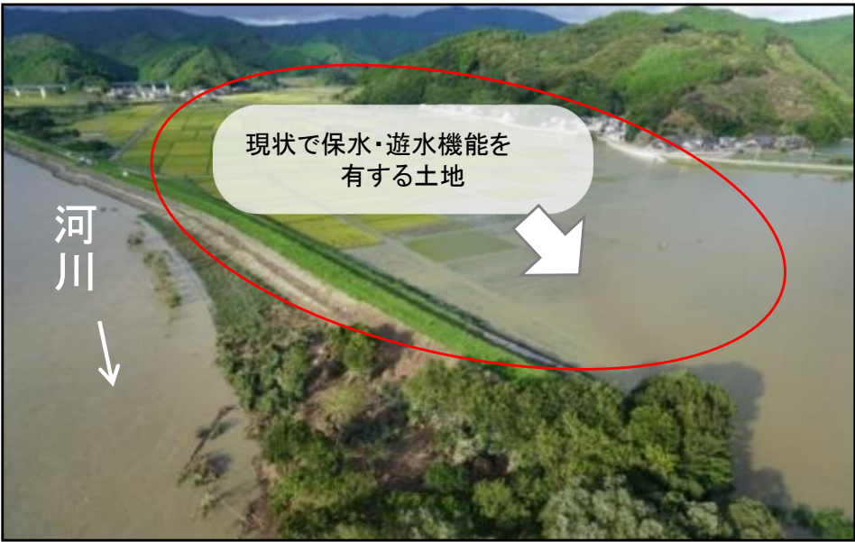
沿川の保水・遊水機能を有する土地
