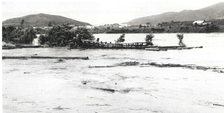
冠水した大和田地区
