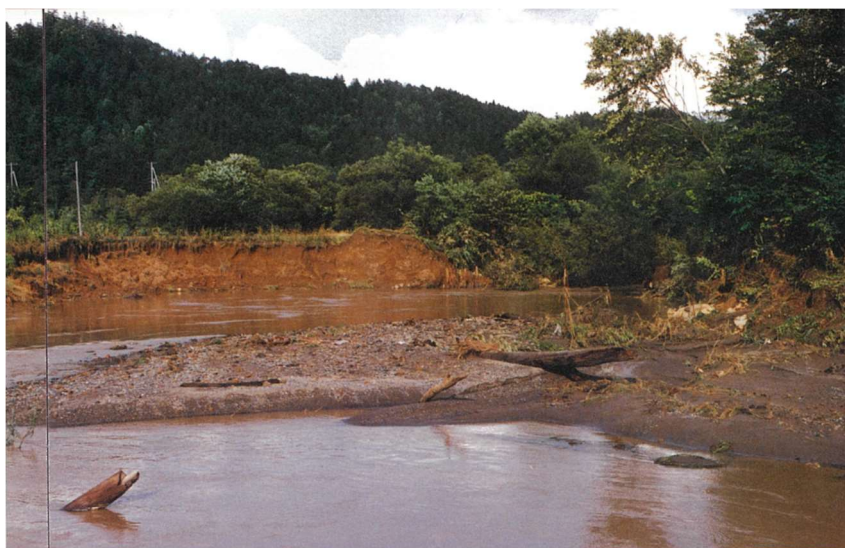
洗堀された河岸
