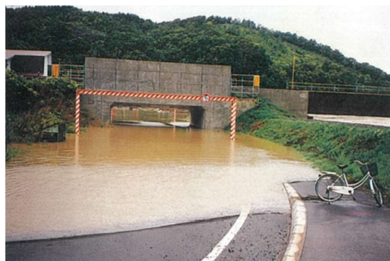
大和田アンダーパス
