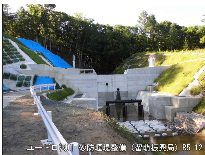
写真 2-1 ユードロ沢川 砂防堰堤整備
