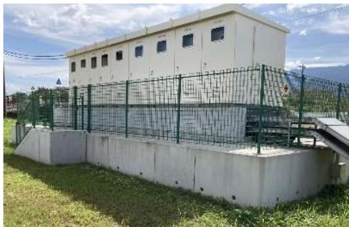
図 4-9 屋外受変電設備の嵩上げ
