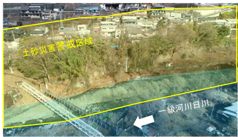
急傾斜地崩壊対策 丸林地区（山梨県）
