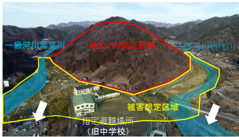
地すべり防止対策 五条地区（山梨県）
