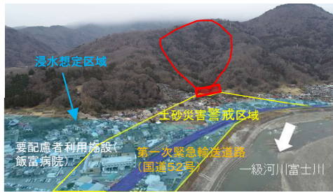
土石流対策 下天神沢川（山梨県）
