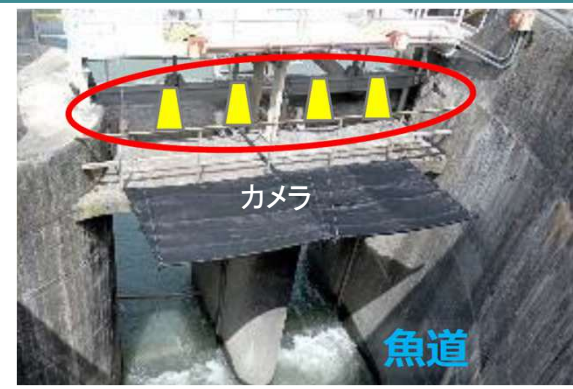
魚道入口にカメラを設置
