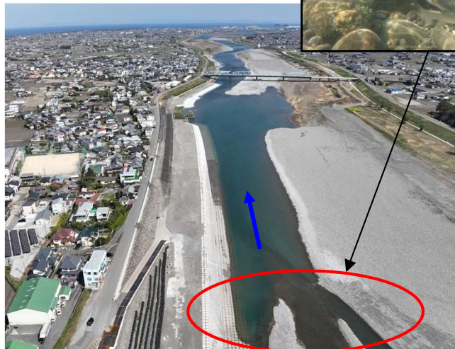
施工後（No. 3付近）
