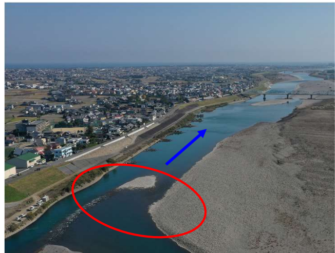
施工前（No. 3付近）
