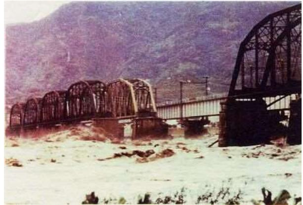
写真 4-9 昭和57年洪水(JR富士川鉄橋の落橋)
