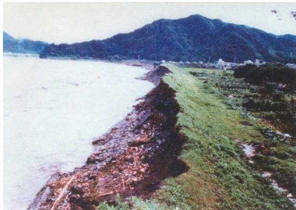
写真 4-8 昭和57年洪水(破堤寸前の堤防浸食)
