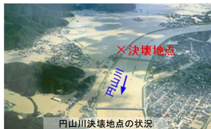
円山川決壊地点の状況
