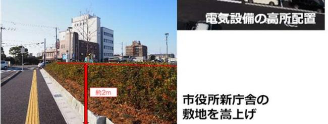
● 高砂市新庁舎建設：高潮による浸水対策として敷地の約2m高上げ、電気設備等の高所配置を実施。
