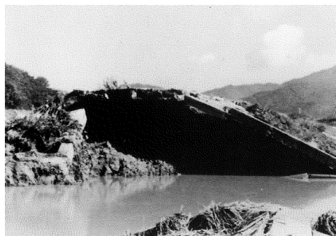
国道178号福田橋付近
