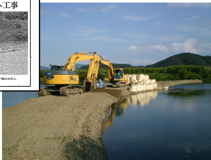
潮止め堰の工事写真
