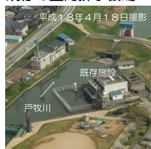
既存の豊岡排水機場
