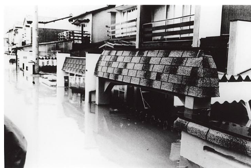
豊岡市内の浸水状況
