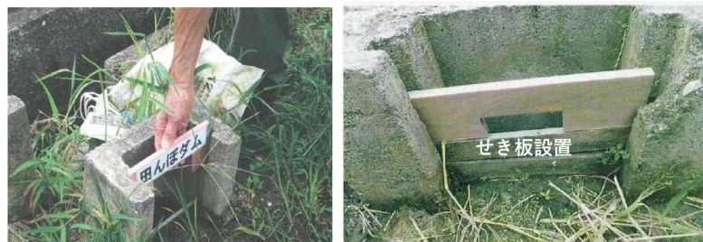
図－4.3.2 田んぼダムの整備事例（加東市）
