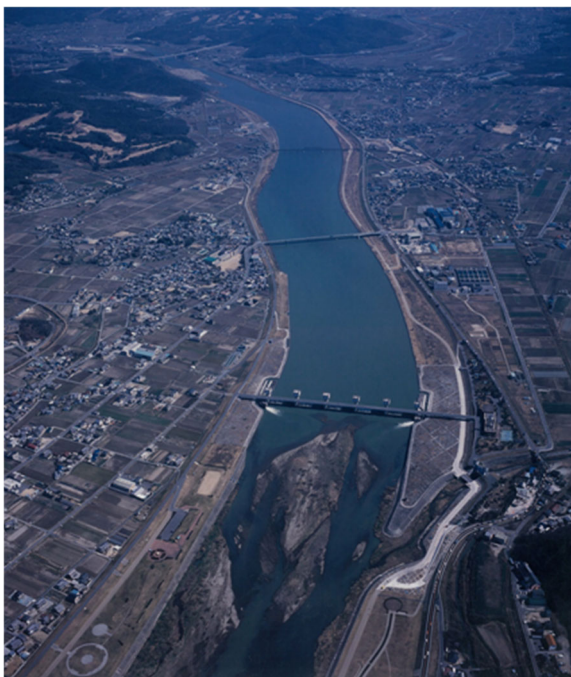
▲ 加古川大堰湛水区間
