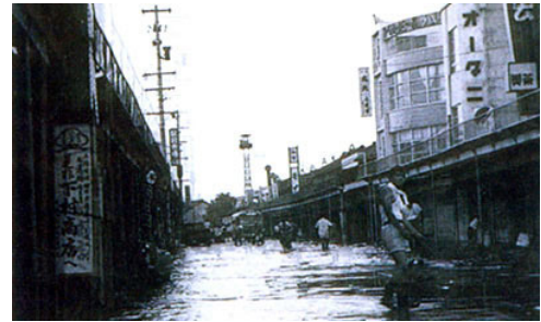
西脇市内の浸水状況
