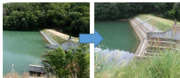
図－4.3.1 ため池の水位調整事例（加東市）
