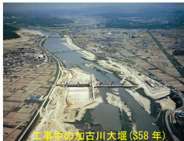
工事中の加古川大堰 (S58 年)
