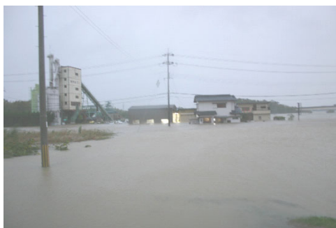
右岸 32.6k の浸水状況
