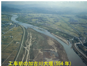
工事前の加古川大堰 (S54 年)
