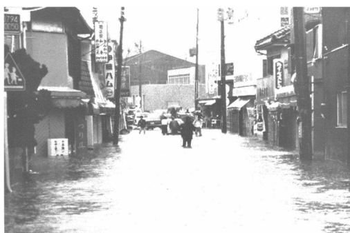
西脇市街地の浸水状況
