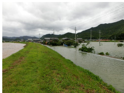
西脇市における浸水状況
