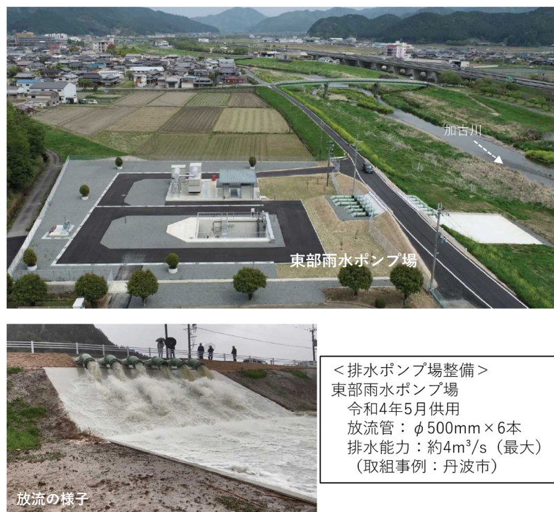
図－4.3.5 排水ポンプ場の整備事例（丹波市）
