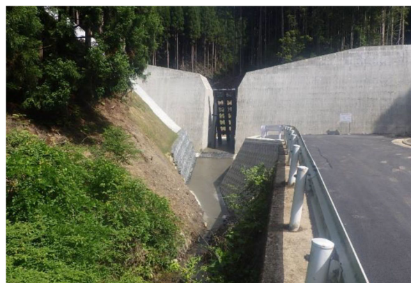
丹波市柏原町上小倉（段山川）の透過型堰堤
