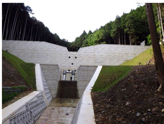
丹波市青垣町沢野（奥塩久谷川）の 不透過型堰堤＋鋼製流木止工
