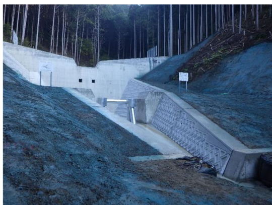
丹波市柏原町見長（奥山川）の不透過型堰堤
