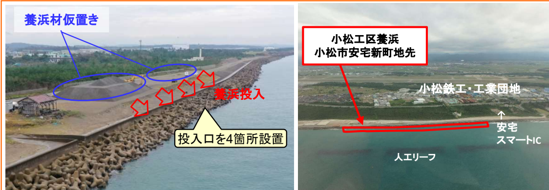
航空写真: 金沢河川国道事務所(撮影) 小松工区における養浜の実施
