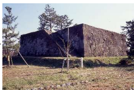
水路に囲まれた「水に浮かぶ城」だった小松城とその城下町が小松市街地の原型かつての水路が梯川や支川となり、低平地に都市が発展。現在は河川・水路・排水機場等の整備により歴史的に形成された市街地の水害対策を実施し、まちづくりと連携
