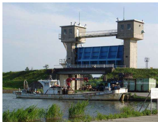
図 7-12 安宅漁港水門
