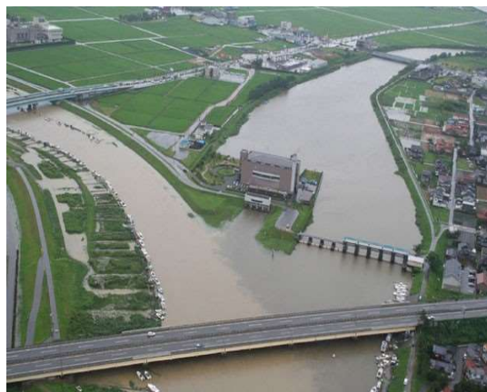
図 9-3 前川排水機場
