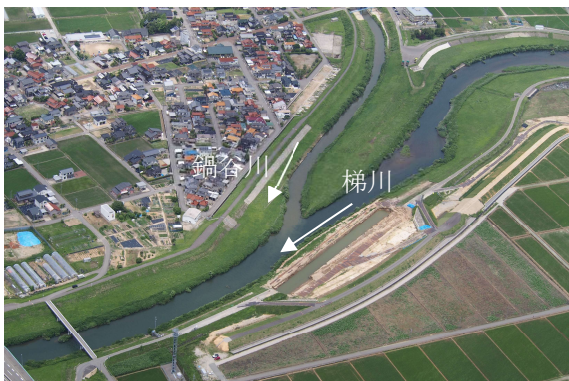
図 8-5 鍋谷川合流部（河口より7.5km）付近
