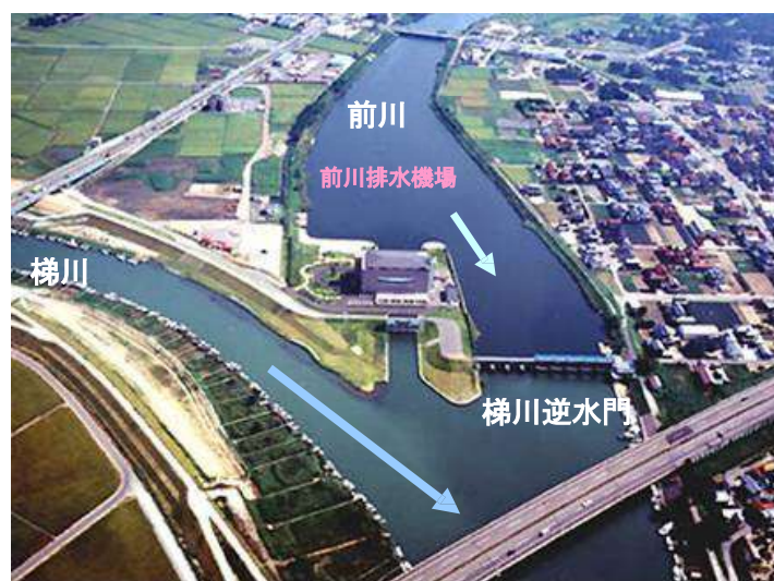
図 4-18 前川排水機場
