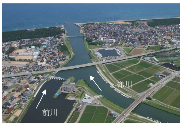
図 8-6 城南橋（河口より1.3km）付近
