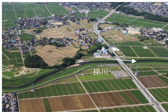
図 8-4 荒木田大橋（河口より9.2km）付近
