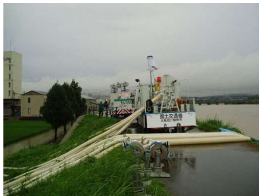
図 9-8 川田川樋管排水ポンプ車
