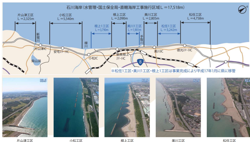
図 5-2 石川海岸の施工区域
