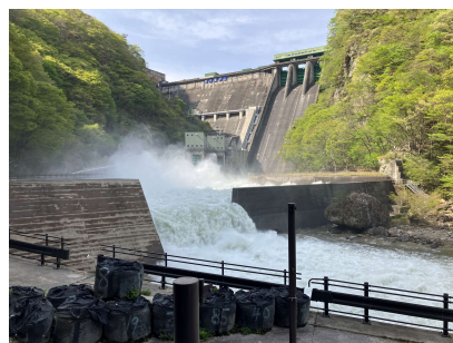
五十里ダム環境放流(約100m³/s)
