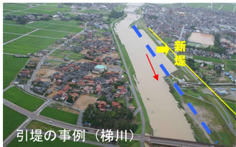
引堤の事例(梯川)
