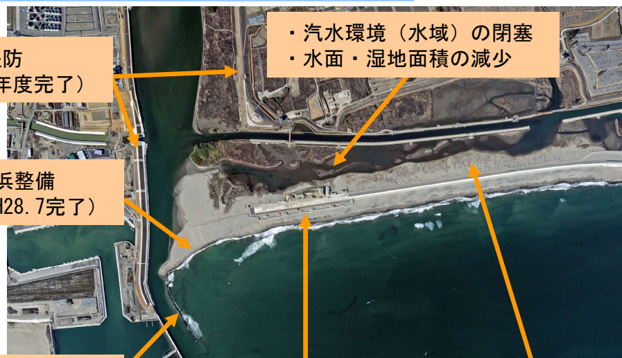
平成29年12月7日（河川堤防復旧完了）
