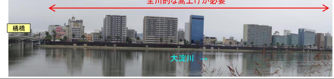
■ 堤防及び橋梁の多くが完成している中、 $10,000\text{m}^3/\text{s}$ 以上の流量についてHWL以下にて流下させるためには、全川的な堤防嵩上げ及び橋梁の架替え等が必要となり社会的影響が大きい
