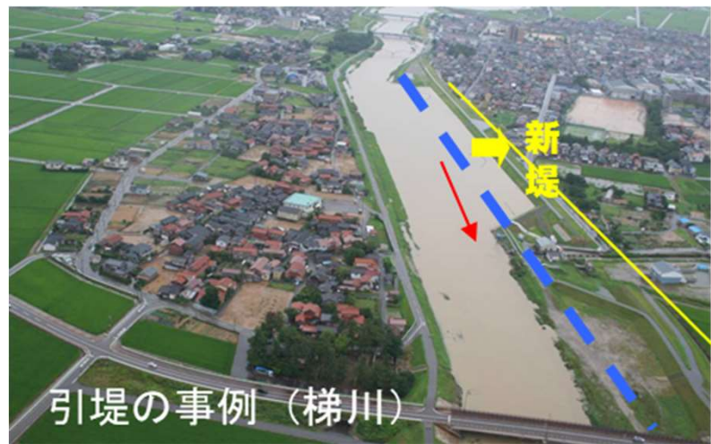
引堤の事例(梯川)
