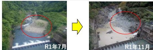
ダム直下流置土箇所の変化
