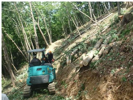
整備中の様子
