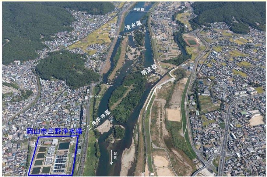
分流部付近の固定堰
