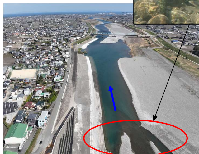
施工後 (No. 3付近)
