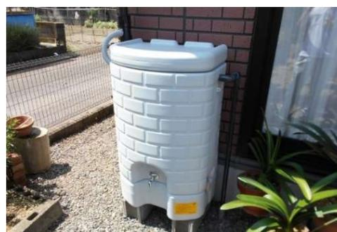
図4-3 雨水貯留タンク設置例
