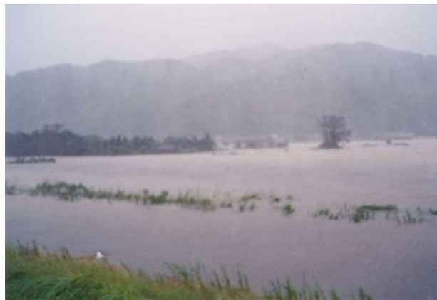
写真 4-5 肝属川右岸 2k000 付近堤内地浸水状況
