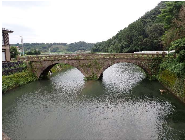
写真 2-38 大園橋（鹿屋市）
