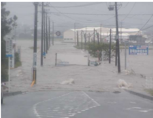
写真 4-12 肝属川右岸 8k000 付近 堤内地浸水状況
