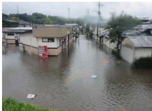
写真 4-17 串良川右岸 3k400 付近 堤内地浸水状況
