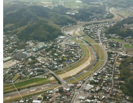
写真 8-10 高山川 (高山橋付近：2k400 付近)
