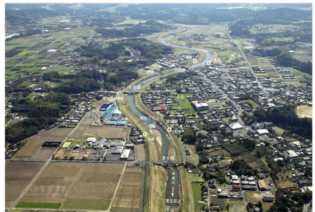
写真 2-27 支川始良川（更生橋付近）
