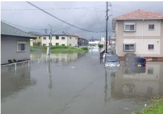
写真 4-15 肝属川左岸 16k000 付近 堤内地浸水状況
