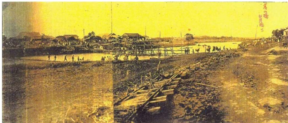
写真 4-1 高山川 2k300 付近（高山橋）被害状況
