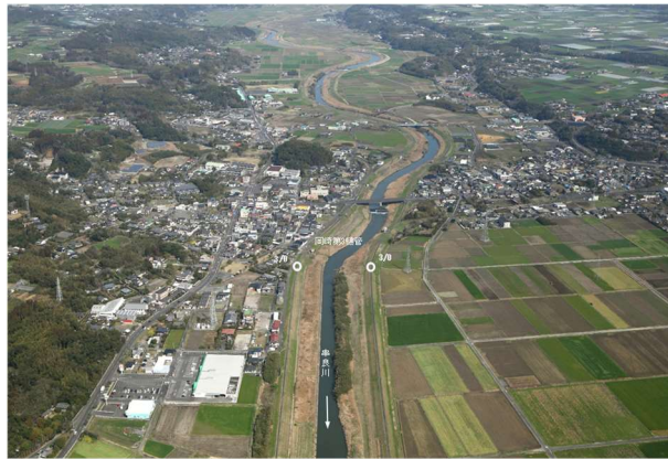
写真 2-25 支川串良川（豊栄橋付近）
