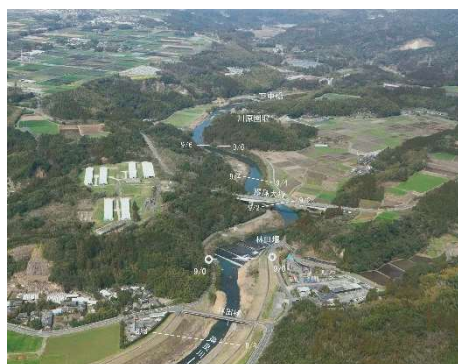
写真 8-7 串良川 (林田堰付近 : 9k000 付近)
