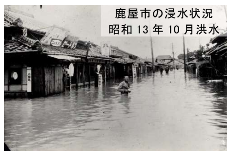
床上まで水に浸かった家 （鹿屋市串良町永和地区）
