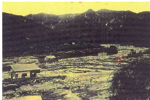
写真 4-2 肝付町後田方野付近被害状況
