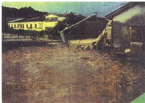
写真 4-4 下谷川 0k200 付近（田崎橋下流左岸）被害状況
