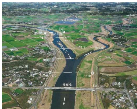
写真 8-6 肝属川下流部 (串良川合流点 4k000 付近)
