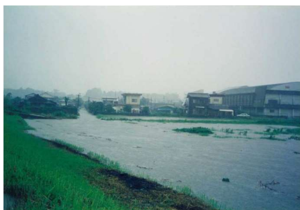
写真 4-8 高山川左岸 2k000 付近堤内地浸水状況
