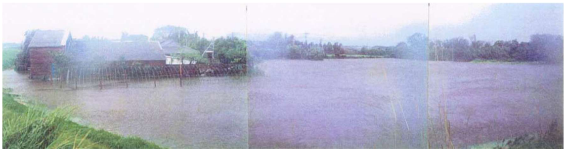
写真 4-10 串良川左岸 0k600 付近堤内地浸水状況
