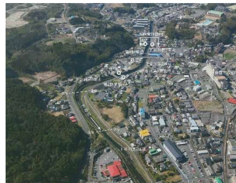
写真 8-12 下谷川 (鹿屋市街地付近：1k000 付近)
