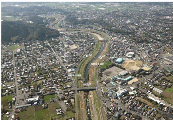
写真 2-26 支川高山川（新前田橋付近）
