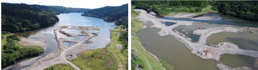
図 3-2(2) 堆砂除去工事状況
