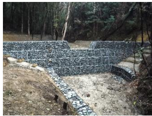
復旧治山工事状況
