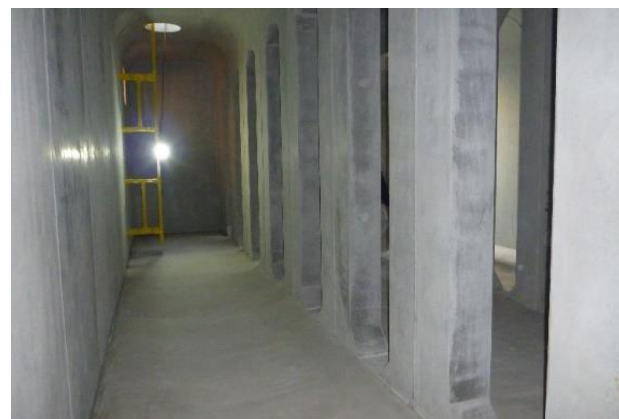
雨水貯留槽の内部状況
