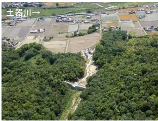
砂防堰堤（榎林川）
