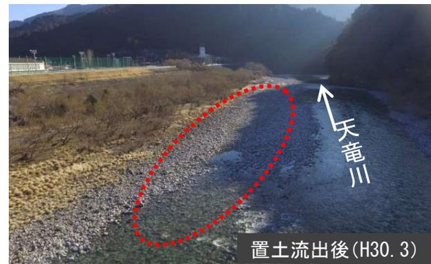
置土流出状況(65.0k付近、約1万m<sup>3</sup>)
