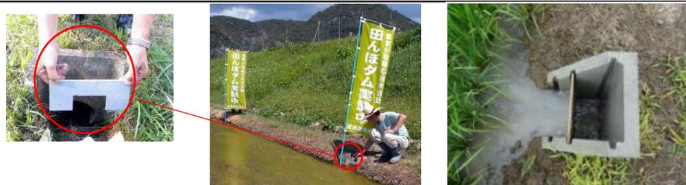
水田の排水口に流出量を抑制するための落水量調整装置を設置する等して、雨水貯留能力を人為的に高める
