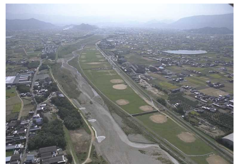
7k 右岸付近の瀬切れ
