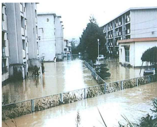
内水被害状況（丸亀市）
