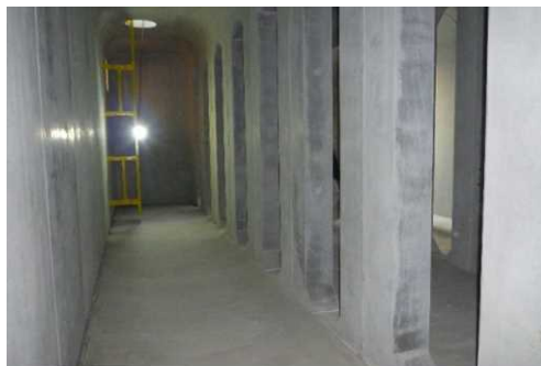
雨水貯留槽の内部状況（宇多津町）
