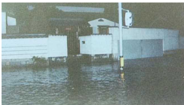
内水被害状況（丸亀市）
