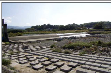
←大川頭首工（右岸から撮影） ・最大 2.8\text{m}^3/\text{s} 、年間 1,440 万 \text{m}^3 取水（届出書） ・河川水 2/3 取水、1/3 を下流へ分水 2/3 取水の内 1/4 は左岸へ分水（覚書） ・取水した水は右岸の溜池群（仁池、打越池、大窪池、小津森池）に貯留し、かんがい補給を行っている
