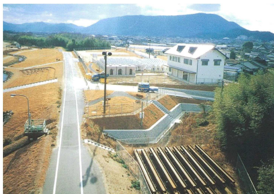
垂水河川防災ステーション
