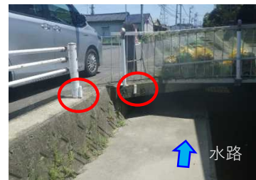
浸水センサ設置状況
