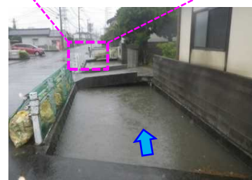
大雨時の水路状況
