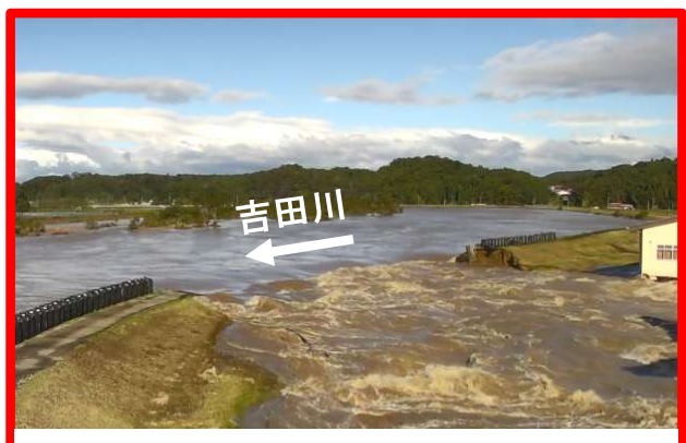
吉田川左岸20.9k付近（R1.10 令和元年東日本台風）
