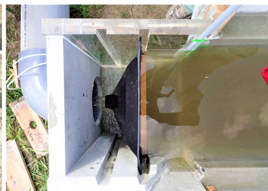
田んぼの排水ますに設置する調整装置
