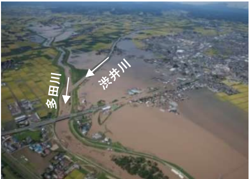
大崎市多田川・渋井川合流点付近の浸水状況
