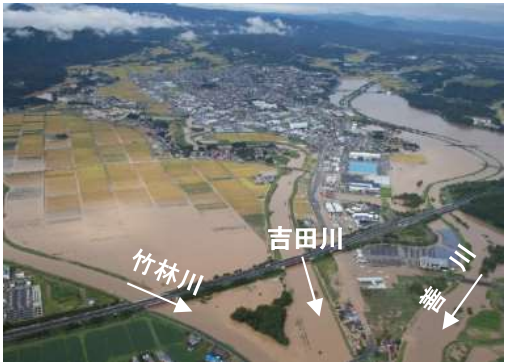
三川合流点付近の浸水状況
