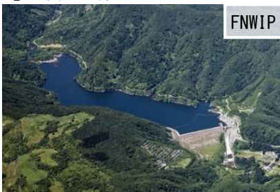
② 鳴瀬川 漆沢ダム
