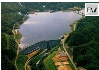
③ 南川ダム
