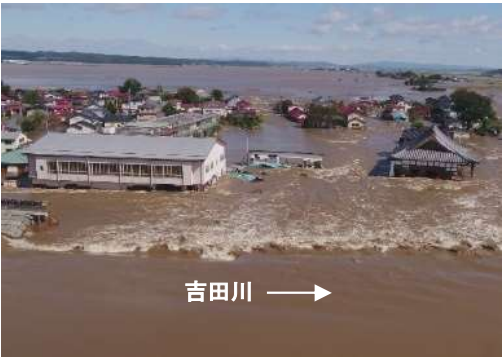
大郷町粕川の堤防決壊状況
