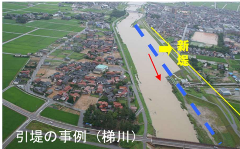
引堤の事例(梯川)
