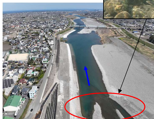
施工後 (No. 3付近)
