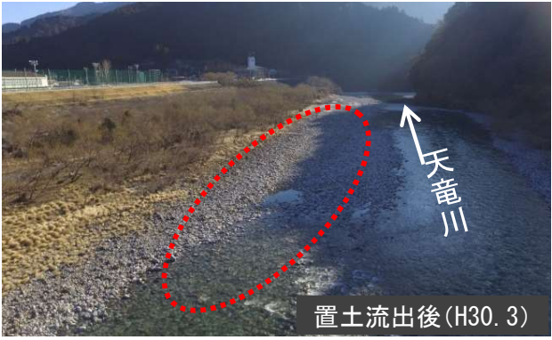
置土流出状況 (65.0k付近、約1万 \text{m}^3 )
