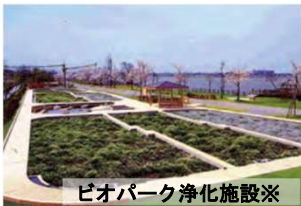
バイオパーク浄化施設※
