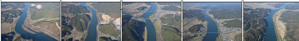
16. 北上川 31k~33k付近 17. 北上川 33k~35k付近 18. 北上川 35k~37k付近 19. 北上川 37k~38k付近 20. 北上川 38k~40k付近
