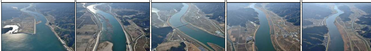
6. 北上川 10k~13k付近 7. 北上川 13k~15k付近 8. 北上川 15k~17k付近 9. 北上川 17k~19k付近 10. 北上川 20k~21k付近
