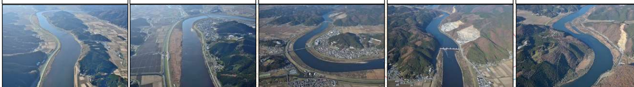
11. 北上川 21k~23k付近 12. 北上川 23k~25k付近 13. 北上川 25k~27k付近 14. 北上川 26k~29k付近 15. 北上川 29k~31k付近
