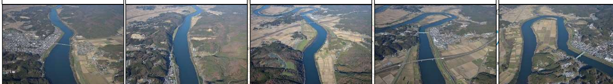
21. 北上川 38k~41k付近 22. 北上川 41k~42k付近 23. 北上川 42k~45k付近 24. 北上川 44k~46k付近 25. 北上川 46k~47k付近
