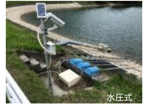
ため池での水位計設置状況
