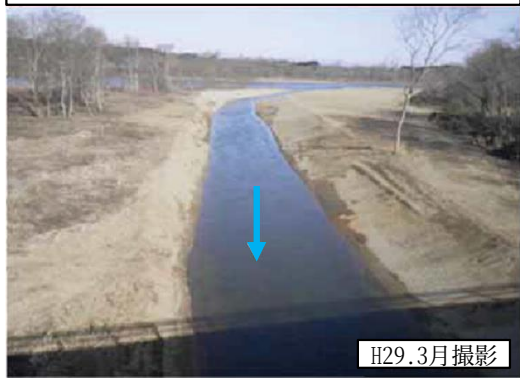
①砂州掘削路施工後（金ヶ崎橋上流側）
