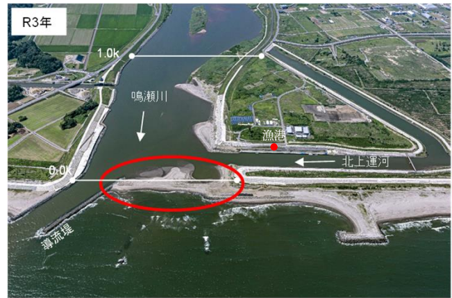
宮城県・東松島市が、再度河口砂州の復元工事を実施
