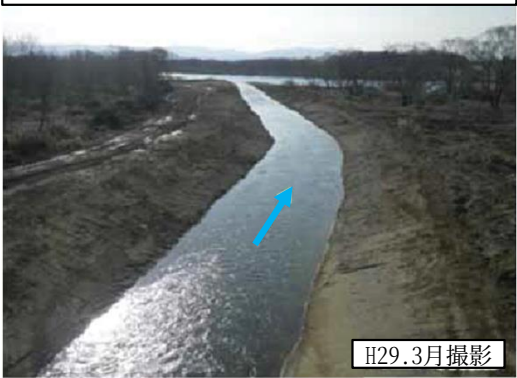
②砂州掘削路施工後（金ヶ崎橋下流側）
