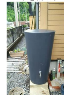
貯留タンク設置例
