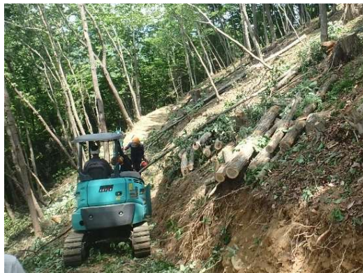
整備中の様子
