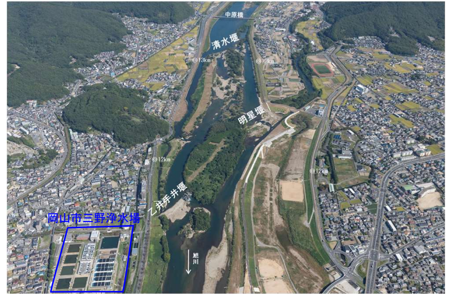
分流利付近の固定堰
