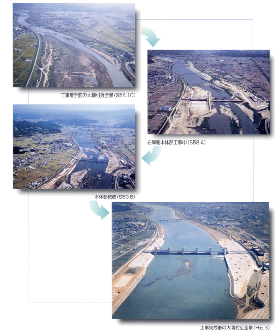
●下流から望む工事の進捗状況
