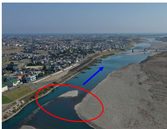
施工前 (No. 3付近)
