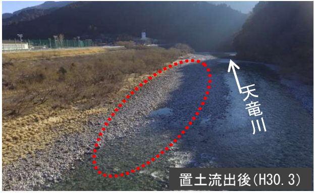
置土流出状況 (65.0k付近、約1万 \text{m}^3 )
