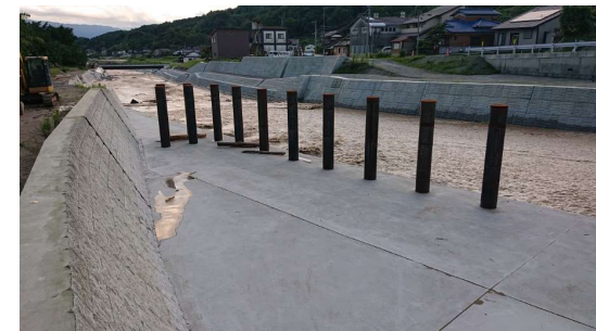
R5.7出水後状況 ※上流の砂防堰堤で捕捉したため 流木はほとんど無かった
