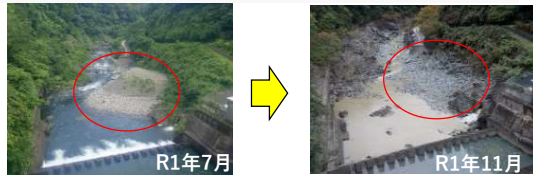
ダム直下流置土箇所の変化
