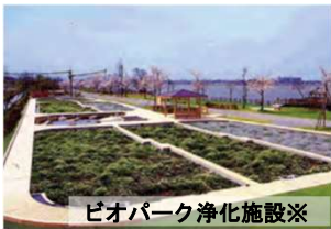
バイオパーク浄化施設※
