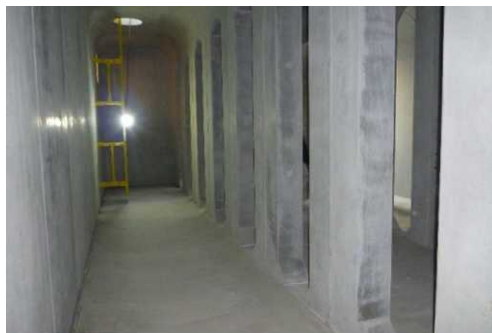
雨水貯留槽の内部状況（宇多津町）
