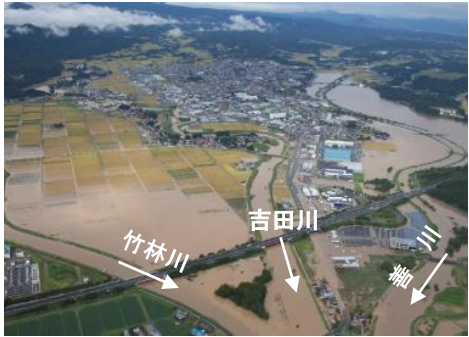
三川合流点付近の浸水状況
