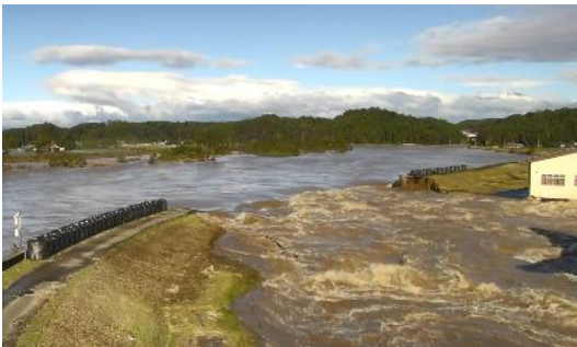
大郷町粕川の堤防決壊状況（決壊直後）
