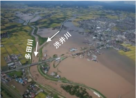
大崎市多田川・渋井川合流点付近の浸水状況
