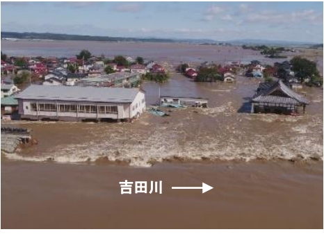
大郷町粕川の堤防決壊状況
