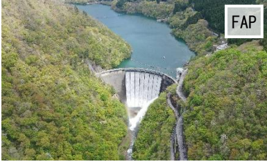
⑧鳴子ダム
