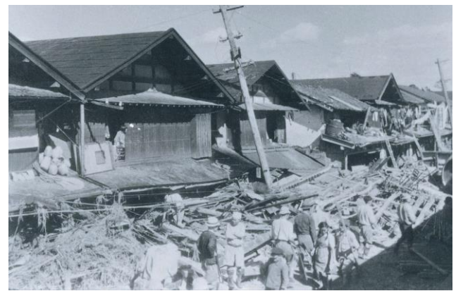
一関市の家屋被害状況
