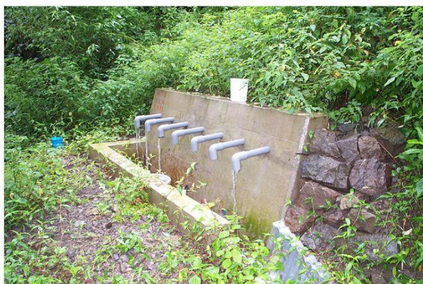
集水井工・横ボーリング工
