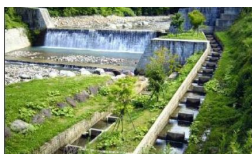
松川第1砂防堰堤
