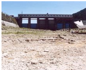
干上がった石淵ダム 平成 6 年（1994 年）7 月渇水状況
