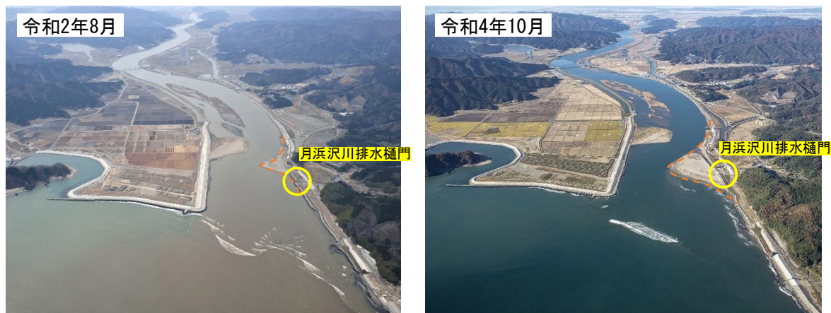
図 8-12 北上川 河口部 月浜沢川排水樋門付近（令和 2 年 8 月・令和 4 年 10 月）
