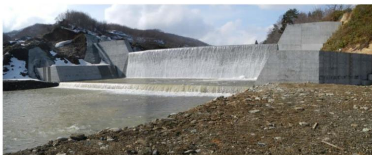
市野々原 2 号砂防堰堤
