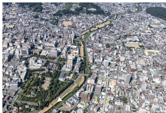
北上川合流点より 1.0km 地点の中津川 市街地を流下しており、遊歩道が整備されている。
