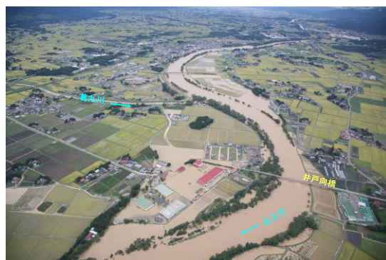
平成 19 年（2007 年）の被害状況 （花巻市井戸向橋付近）
