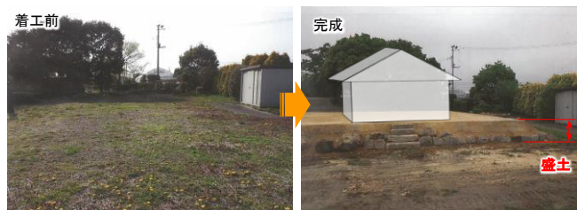
図 4-34 宅地嵩上げによる工事事例（大崎市の例）
