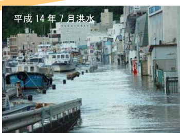
旧北上川河口付近の浸水状況 満潮時と重なり水位が上昇
