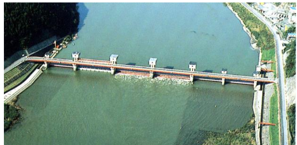
北上大堰（昭和 54 年（1979 年）竣工）
