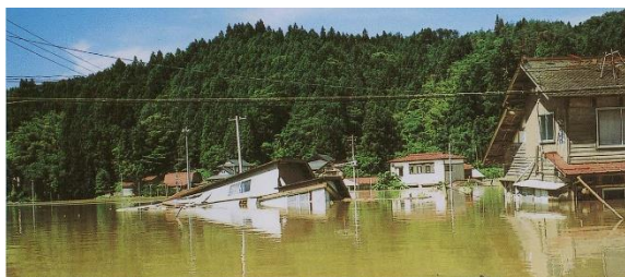
平成 14 年（2002 年）の被害状況（砂鉄川）
