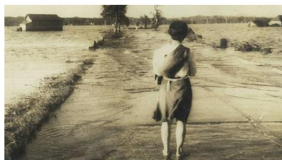
カスリン台風の被害状況（大崎市三本木橋梁）
