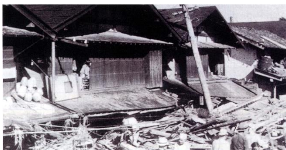
カスリン台風の被害状況（一関市大町街路）
