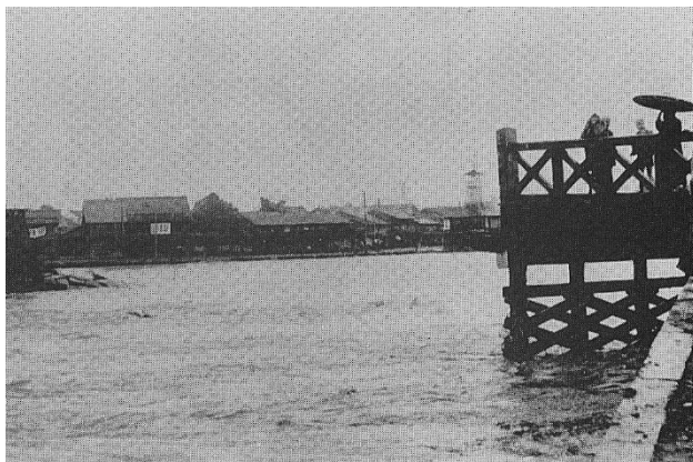
明治 43 年（1910 年）洪水の被害状況
