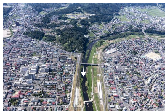
北上川合流点より 6.0km 地点の磐井川 周辺は市街地で、河川敷はグラウンド等に用いられている。
