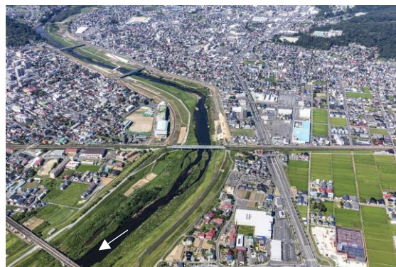
北上川合流点より 5.0km 付近の磐井川 周辺は市街地で、河川敷はグラウンド等に用いられている。
