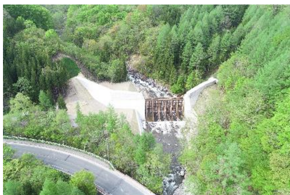
荒沢砂防堰堤
