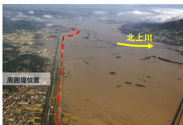
平成 2 年（1990 年）7 月洪水時の浸水状況 （周囲堤が整備途上のため未整備区間より浸水）
