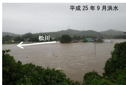
松川（古川橋）の浸水状況
