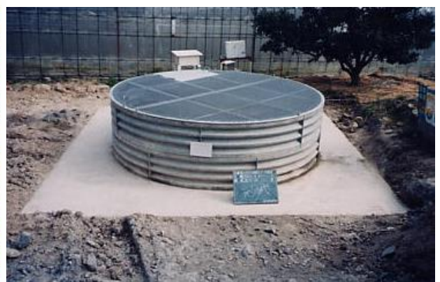
集水井工・横ボーリング工
