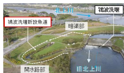
分流施設における魚道の設置
