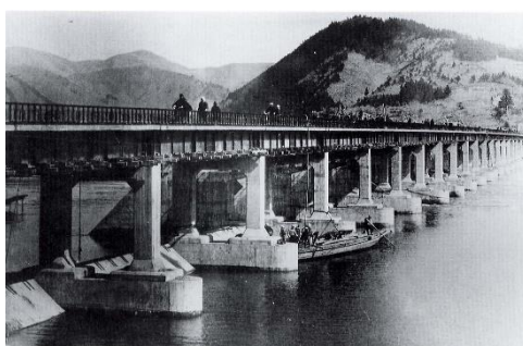
飯野川橋と可動堰
