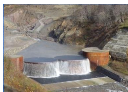
湯浜砂防堰堤
