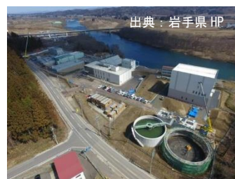
新北上浄水場全景（R6.3 末時点）
