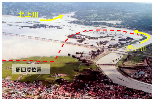
昭和 56 年（1981 年）8 月洪水時の浸水状況 （周囲堤が未整備のため広範囲で浸水）
