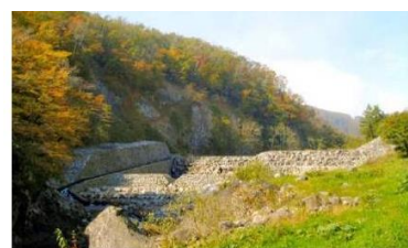
葛根田川第1砂防堰堤
