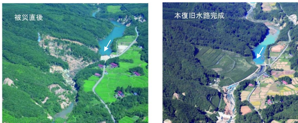
河道閉塞 磐井川（一関市 市野々原地区）
