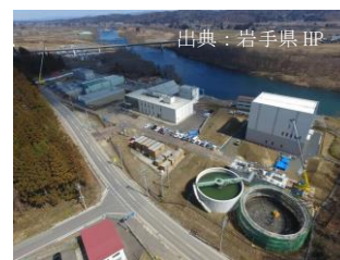
新北上浄水場全景（R6.3 末時点）
