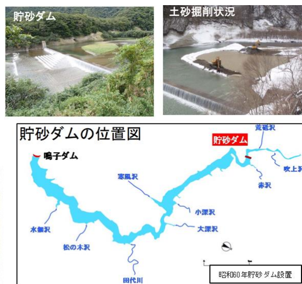
鳴子貯砂ダム、土砂掘削状況
