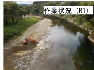
四十四田ダム貯砂床止め、土砂掘削箇所
