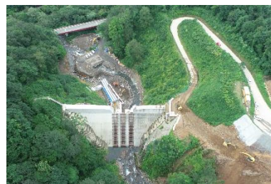
シガクラ沢砂防堰堤
