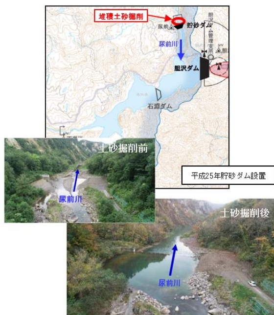
胆沢貯砂ダム、土砂掘削状況
