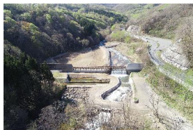
竜川第 3 砂防堰堤
