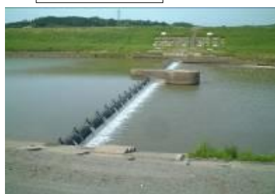
若針潮止堰 (S48 (1973) 完成)
