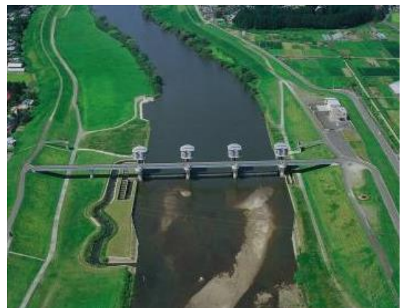
鳴瀬川中流堰
