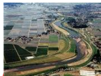
鳴瀬川中流堰(H14 (2002) 完成)
