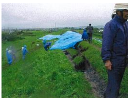
宮城県北部地震により被災した堤防の復旧状況
