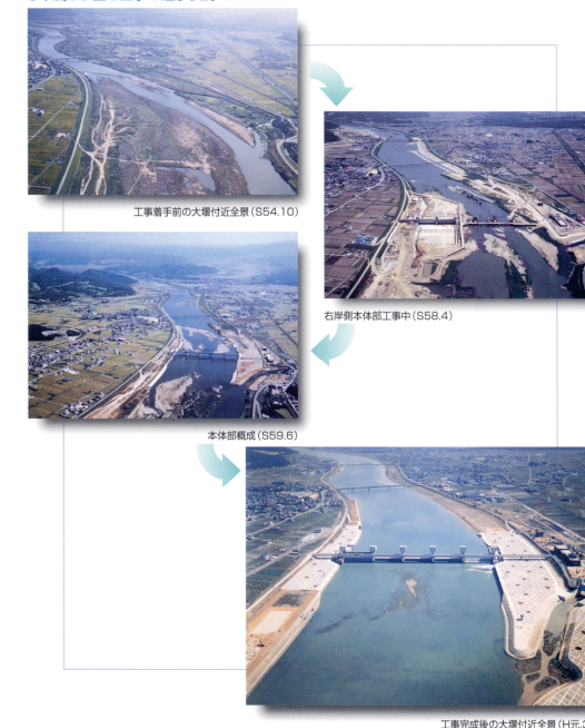
●下流から望む工事の進捗状況
