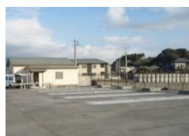
曝気装置付浄化施設
