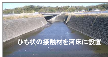
簡易な浄化施設(5号排水路)
