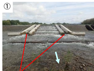
呼び水水路の設置による呼び水機能の強化
