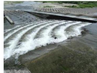
扇形魚道の新設
