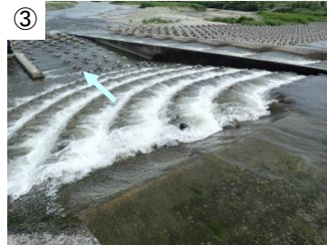
水叩きに滞留する魚類が上れるよう扇形魚道を新設
