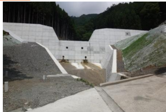
砂防施設の整備事例（恋ヶ谷） (出典：三重県)
