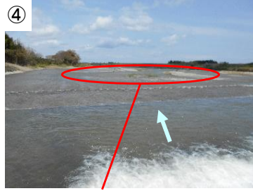
魚道に近づきやすくなるよう堆積土砂を撤去
