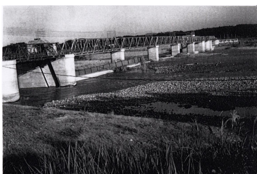
櫛田川頭首工(可動化前の櫛田可動堰)
