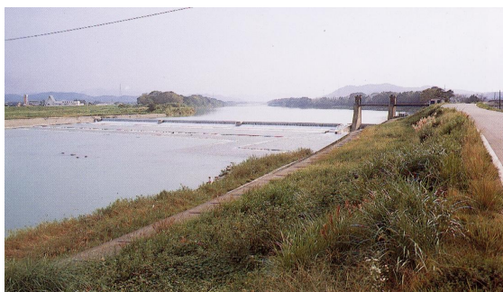
櫛田川第一頭首工
