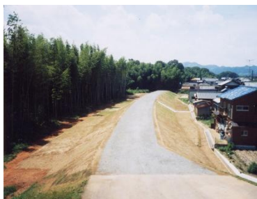
射和地区築堤 (14k 付近)
