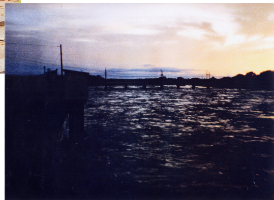
洪水時の状況（7.8k 付近）
